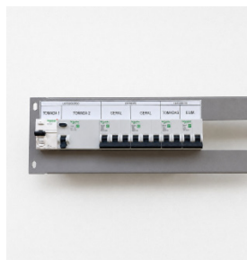
Sem tampa disjuntor furo DIN
